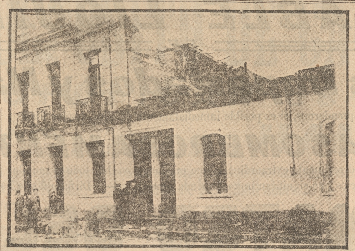
CASA DE LA CALLE COCHRANE, CUYO SEGUNDO PISO FUE DERRUMBADO QUEDANDO VARIOS MORADORES AISLADOS. RESULTO HERIDA EN ESTA CASA LA SRITA. ARMANDA CID, ESTUDIANTE DE LEYES DE LA UNIVERSIDAD DE CONCEPCION
