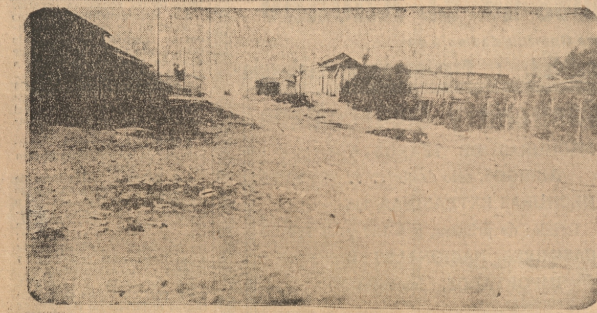
Las aceras no se conocen en la calle Santa María, como puede apreciarse en la fotografía
