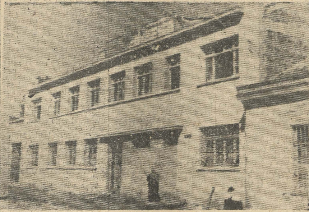
La reconstrucción progresa, se acentúa de día en día. — Edificio construido en calle Cochra, entre Caupolicán y Rengo. — Arquitecto señor Alfredo Benavides.
