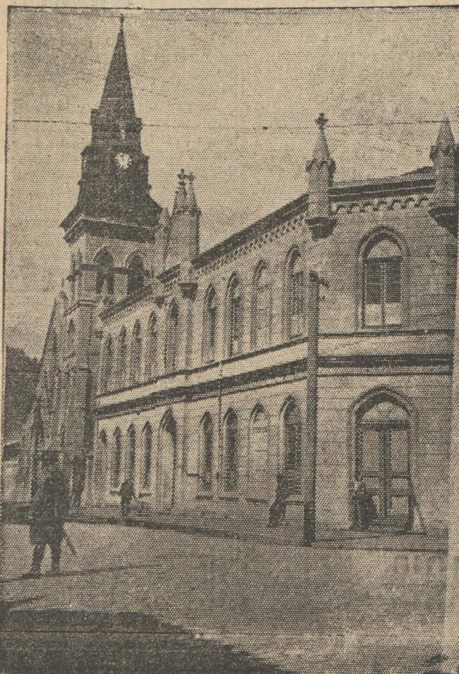
La Iglesia Parroquial de Lota Alto antes del terremoto
