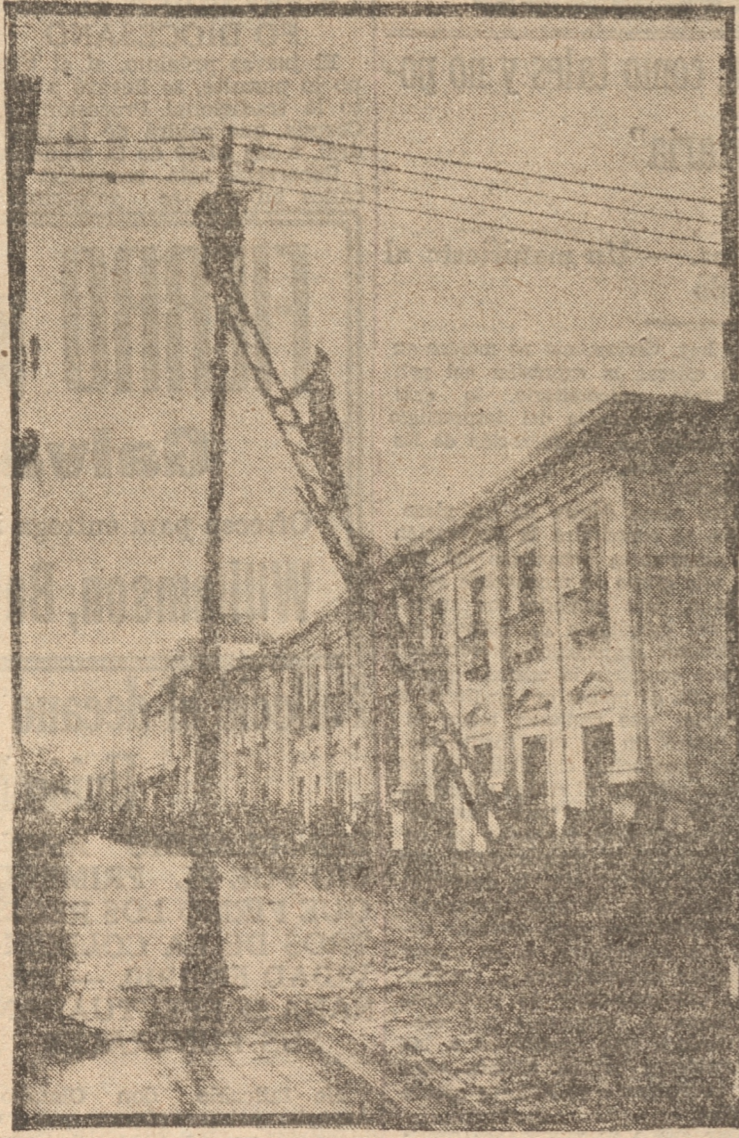
Ayer se trabajó intensamente en la reparación de las líneas de la red del servicio eléctrico, operarios ocupados en esta faena
