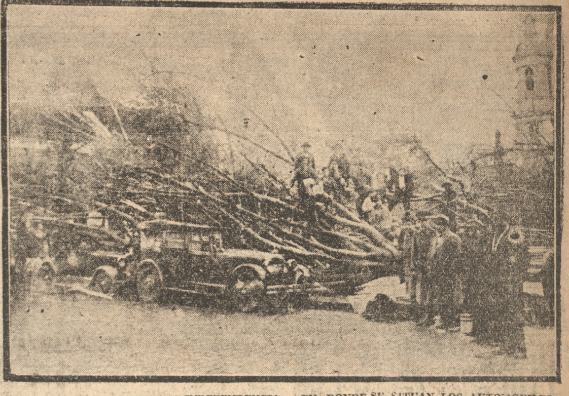
COSTADO NORTE DE LA PLAZA INDEPENDENCIA, EN DONDE SE SITUAN LOS AUTOMOVILES DE ALQUILER. PUEDEN VERSE NUMEROSOS TILOS DERRIBADOS POR EL HURACAN Y DOS AUTOMOVILES APLASTADOS POR LOS ARBOLES
