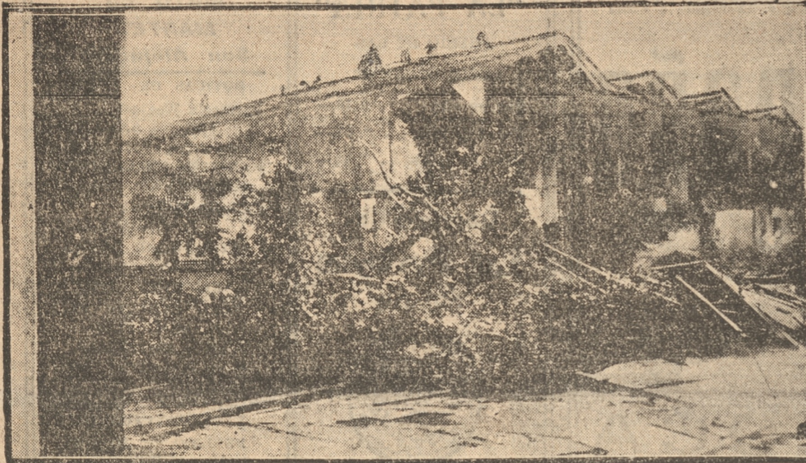
OTRA VISTA DE LA FABRICA DE CALZADO DE BOLEDA, RIVES Y CIA. EN PRIMER TERMINO ARBOLES DEL PARQUE ECUADOR ARRANCADOS DE RAIZ, LAS VIGAS DE LA TECHUMBRE DEL EDIFICIO FUERON PROYECTADAS SOBRE EL CHALET DEL DOCTOR WILHELM
