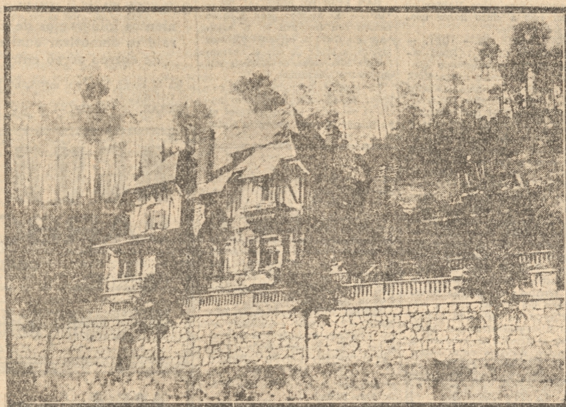
CHALET DE PROPIEDAD DEL DR. DON OTIMAR WILHELM QUE FUERA DE LOS DETERIOROS QUE LE CAUSO EL TORNADO MISMO, RECIBIO LOS IMPACTOS CAUSADOS POR LAS VIGAS DEL EDIFICIO DE LA FABRICA DE CALZADO QUE PERFORARON EL TECHO.
