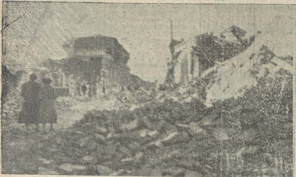
BARROS ARANA ESQUINA HIPOLITO SALAS, DONDE SE ENCONTRABAN ENTRE OTROS EDIFICIOS LA CASA WILLIAMSON Y TEMPLO DE SAN FRANCISCO
