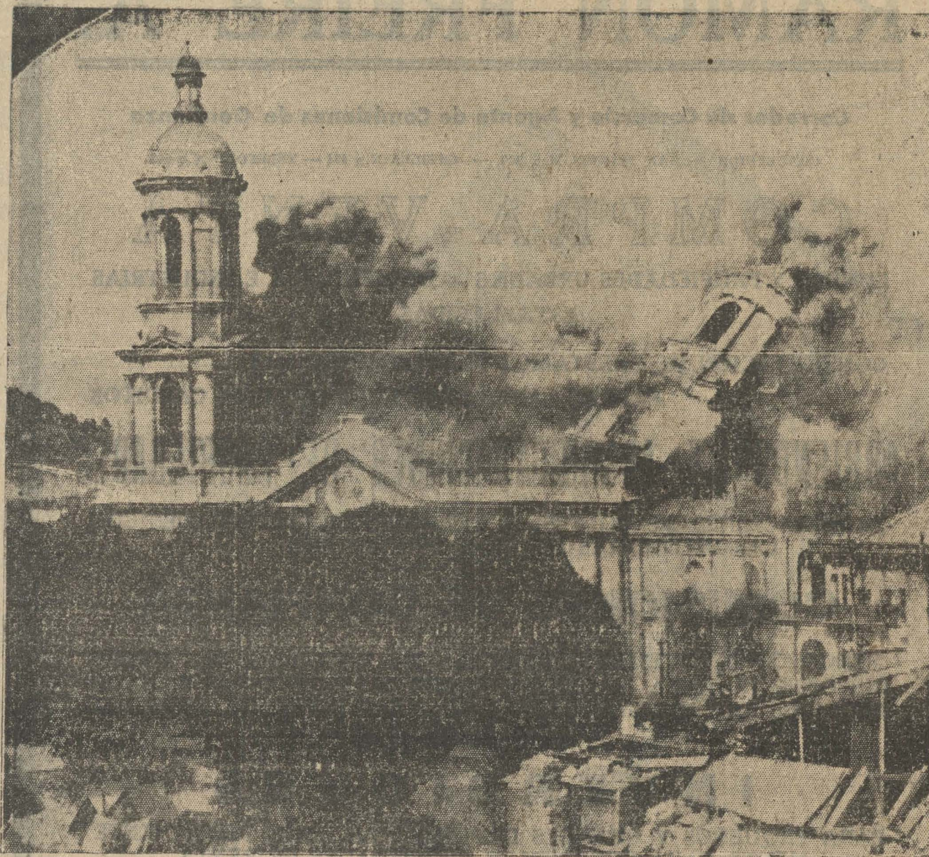
CAIDA DE LA PRIMERA TORRE DE LA CATEDRAL, AL IMPULSO DE UNA CARGA DE 60 Kigs. DE TROTLY
