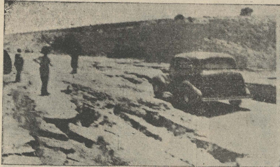
GRIETAS EN EL CAMINO A BULNES
