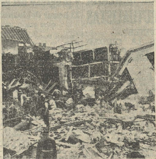
RUINAS DE LA CASA WILLIAMSON. EL EDIFICIO FUE COMPLETAMENTE DES-TRUIDO
