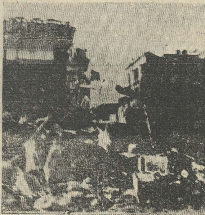
OTRO ASPECTO DEL ESTADO EN QUE QUEDO LO QUE FUERA UN GRAN EDIFICIO: LA CASA WILLIAMSON
