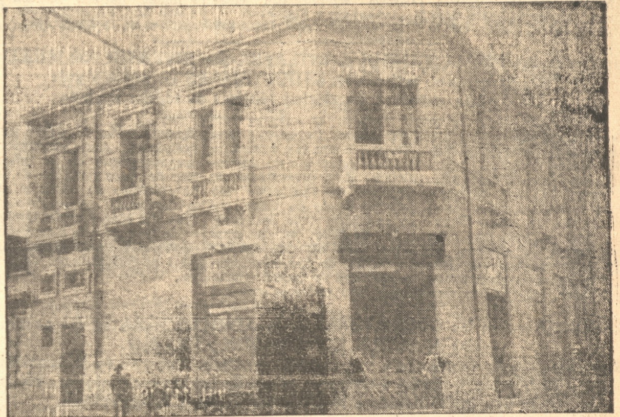
EL ALMACÉN INSTALADO EN CALLE ARTURO PRAT ESQUINA FREIRE
