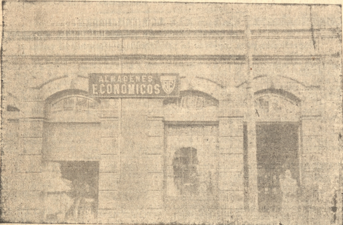
EN CALLE FREIRE ENTRE RENGÓ Y SAUPOLICÁN SE INSTALÓ OTRO
