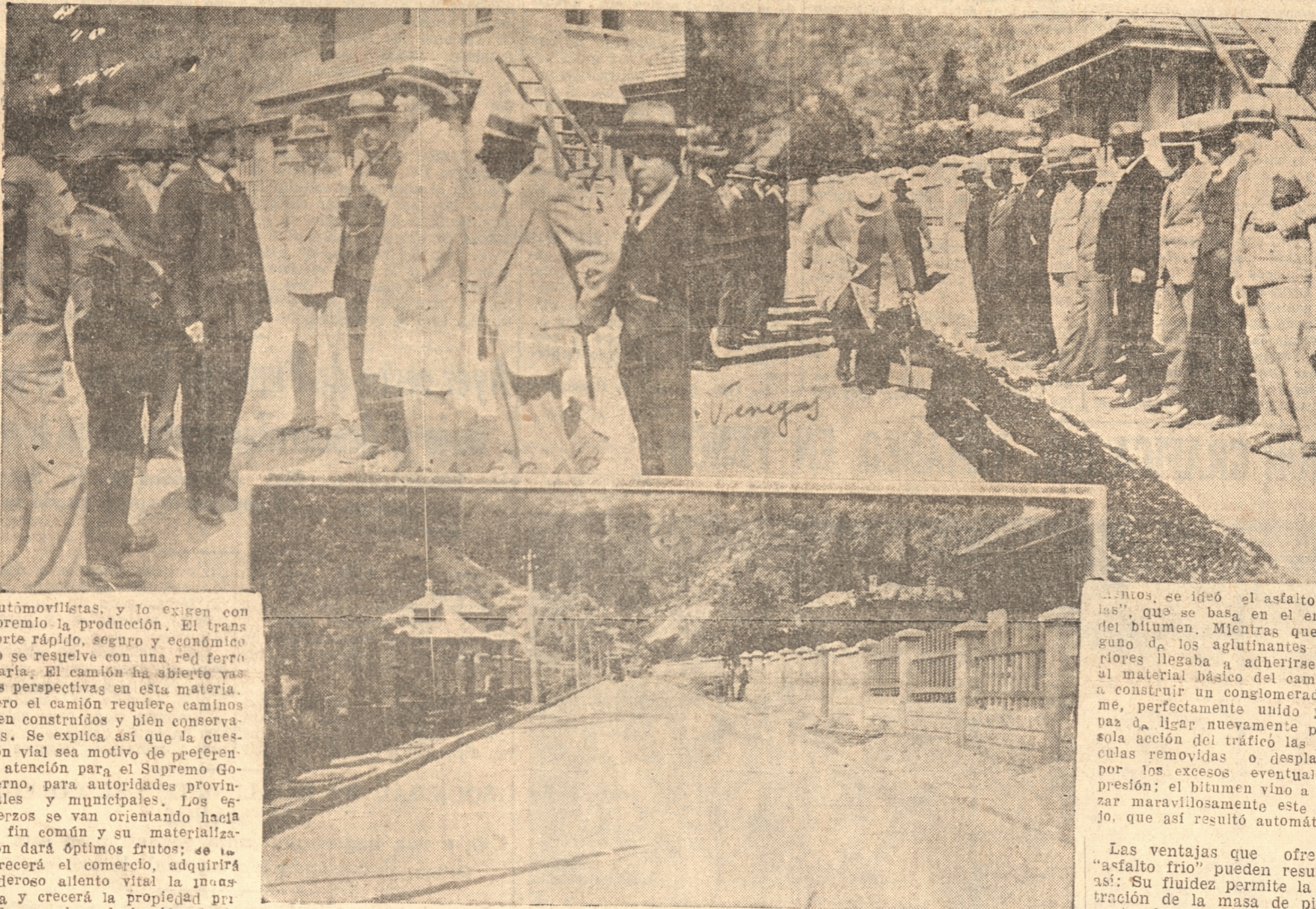
EL INGENIERO SEÑOR GILBERT EXPLICA AL SEÑOR ALCALDE Y DEMAS PERSONAS LA APLICACION DEL ASFALTO "COLAS". — 2.— EL SEÑOR GILBERT COLOCANDO SOBRE EL CHANCADO EL BITUMEN, EN LA DEMOSTRACION PRACTICA. — 3.— UNA DE LAS CALLES DE LA POBLACION "QUINTA SOFIA" QUE SE ASPALTARA PRIMERO, Y EN LA CUAL SE HIZO LA DEMOSTRACION.
