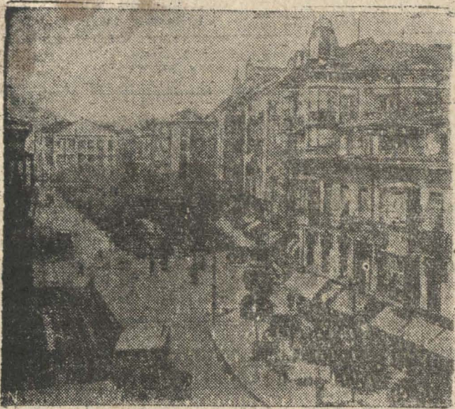
Recientemente un terrible huracán que proveniente del Atlántico, pasó por Portugal, azotó con furia la parte norte de España, destruyendo más de doscientos hogares en Santander. Fue seguido el huracán por un violento incendio que dejó sin hogar a 30.000 personas. El International Illustrated News presenta una fotografía de la hermosa ciudad hispana antes del siniestro. (I. I. News).
