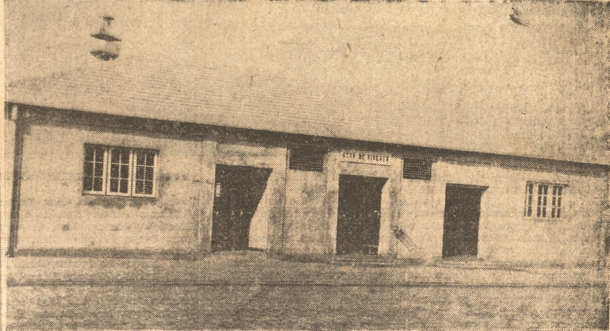
FACHADA DEL EDIFICIO DE LA NUEVA CASA DE VIVERES
