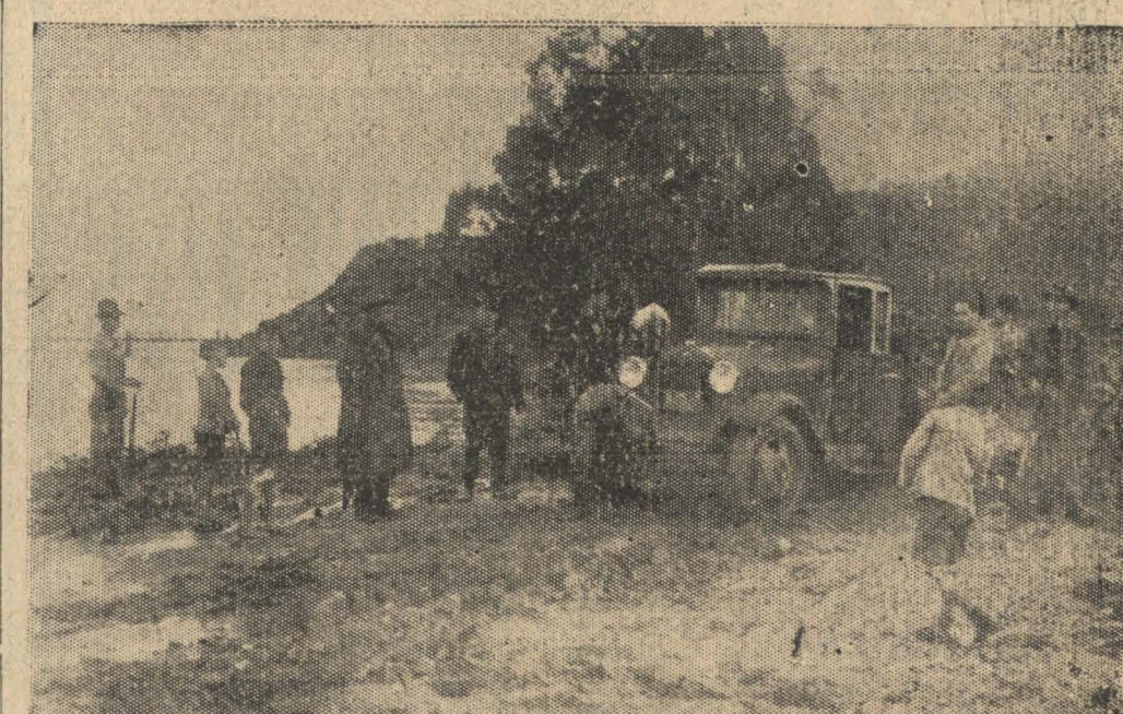
En este lugar, cerca de la población Pedro del Río, hace varios días que se está trabajando en hacer terraplenes y otras obras de defensa. Anoche el río arrasó con todo. En la foto tomada ayer tarde, aparece personal de la Municipalidad que trabajó arduamente en las obras de emergencia.
