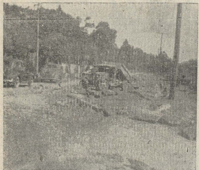
Estado de los trabajos de reparación de la Avenida P. de Valdivia
