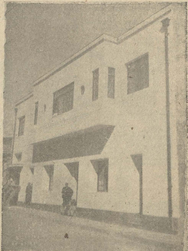
Una hermosa construcción recién terminada en Talcahuano.
