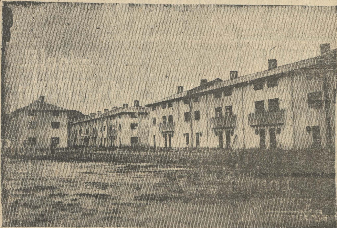
Tres Pabellones Rieloff recientemente entregados para habitaciones de los obreros, habiendo dos más por terminarse y en futura construcción otros.
