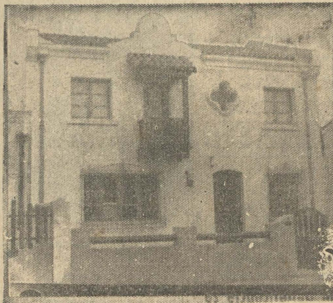
Edificio de la señora Lorenza A. de Etchegoyen, calle Ongolmo N.º 437.
