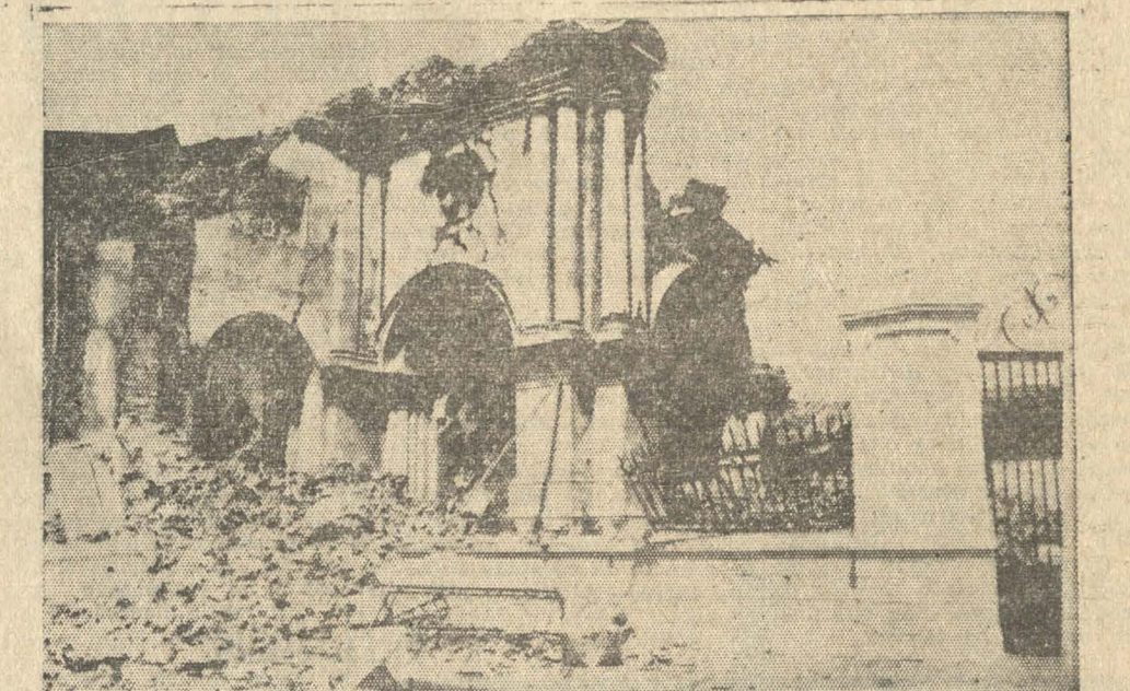
La torre de San Agustín se desplomó aquella noche. Sólo un montón de escombros señala el lugar donde fué construida.
