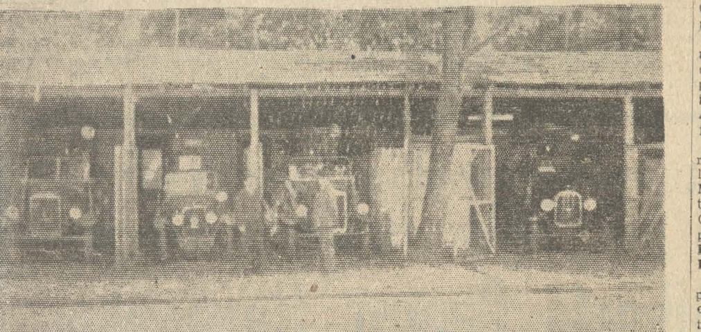
Galpones de emergencia en plena plaza de armas donde se guardan actualmente los carros que pertenecen al Cuerpo de Bomberos de Chillán
