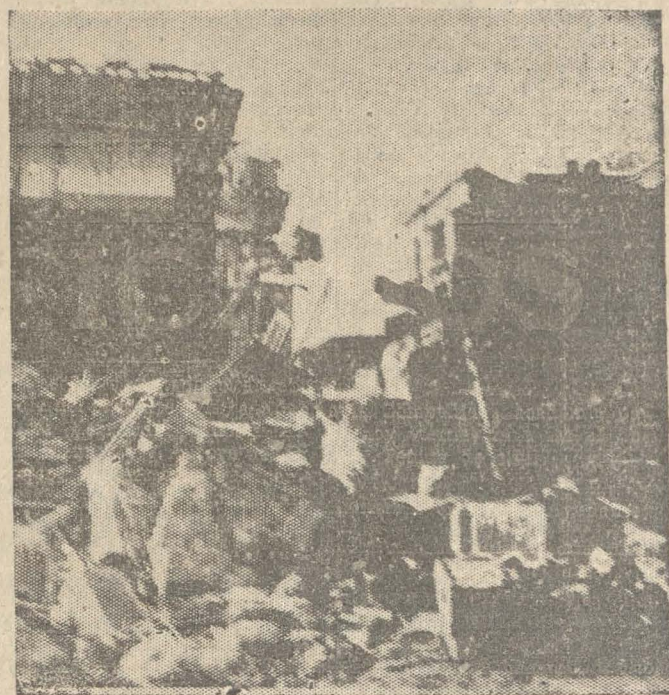
Aspecto de la calle Salas, frente al edificio de Williamson Balfour. Los escombros cubren totalmente la calle
