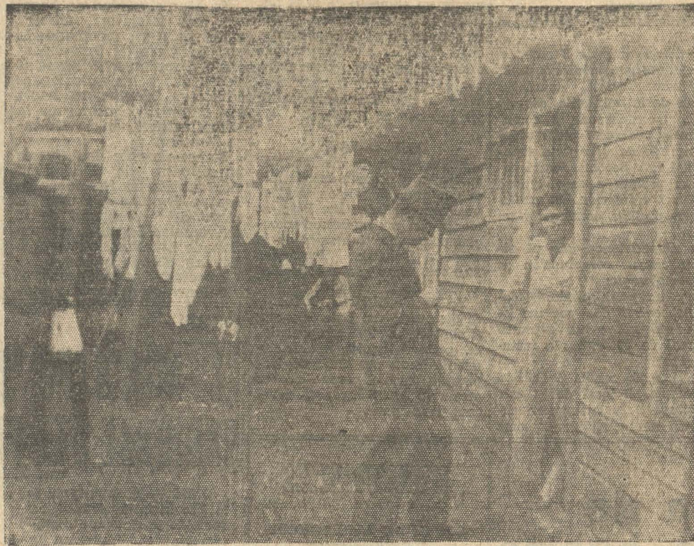
UN ASPECTO DEL CONVENTILLO DE CALLE BULNES 453.— LA ROPA ESTA TENDIDA APROVECHANDO EL POCO SOL QUE QUEDA DE LA TARDE DEL VIERNES.— HOY DEBE ENCONTRARSE DE NUEVO COMPLETAMENTE MOJADA POR LA COPIOSA LLUVIA DEL SABADO
