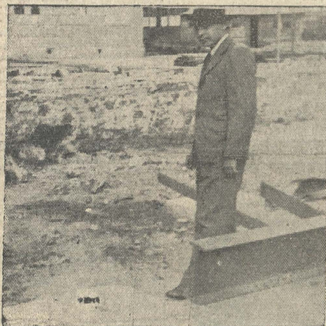
Este joven de buena voluntad está al borde de la zanja de la Estación que constituye un peligro para los viajeros.
