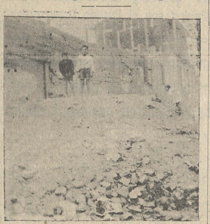
Estos son los escombros que deben retirarse
