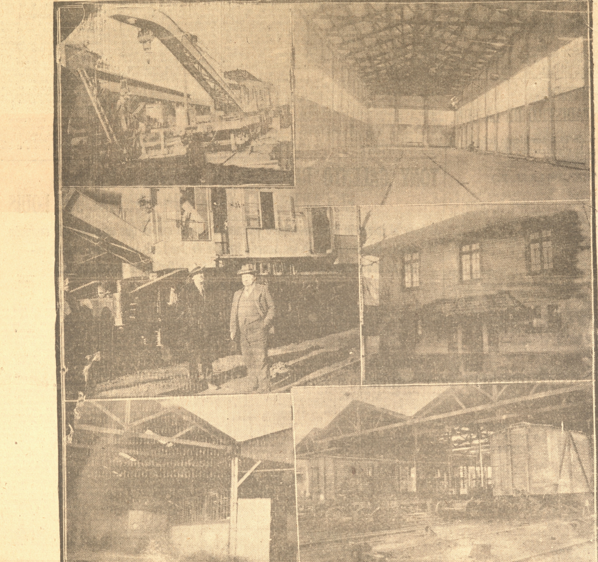
¡MAMOS UN MOSAICO DE LA MAESTRANZA: Los señores Luis Alvarado y Adolfo Sprohlie Melo, jefe zonal e ingeniero jefe de la Maestranza de los Ferrocarriles del Estado de Concepción. — El poderoso pescante, capaz de levantar 60 toneladas recientemente llegado de Alemania para el taller de coches. — Vista del taller de coches. — Fotografía del edificio de Administración de la Maestranza. — El moderno taller de maquinarias, que será habilitado dentro de poco
