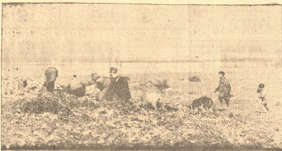
Un aspecto del basural a orillas del Bio-Bio, y que tanta molestia ocasiona a los vecinos que habitan en ese sector
