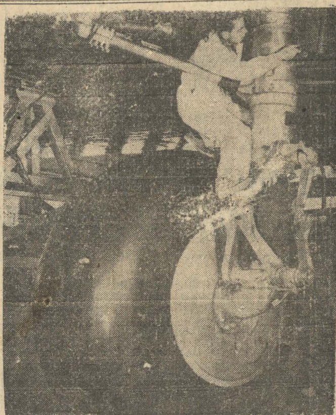
Esta rueda de aterrizaje da una idea del gigantesco tamaño del avión de bombardero B-19 que se construye en Santa Mónica, California. El mecanismo de aterrizaje, solamente, pesa 9.800 libras. Será el lanza-bombas más grande del mundo. — (Foto I. I. News.)
