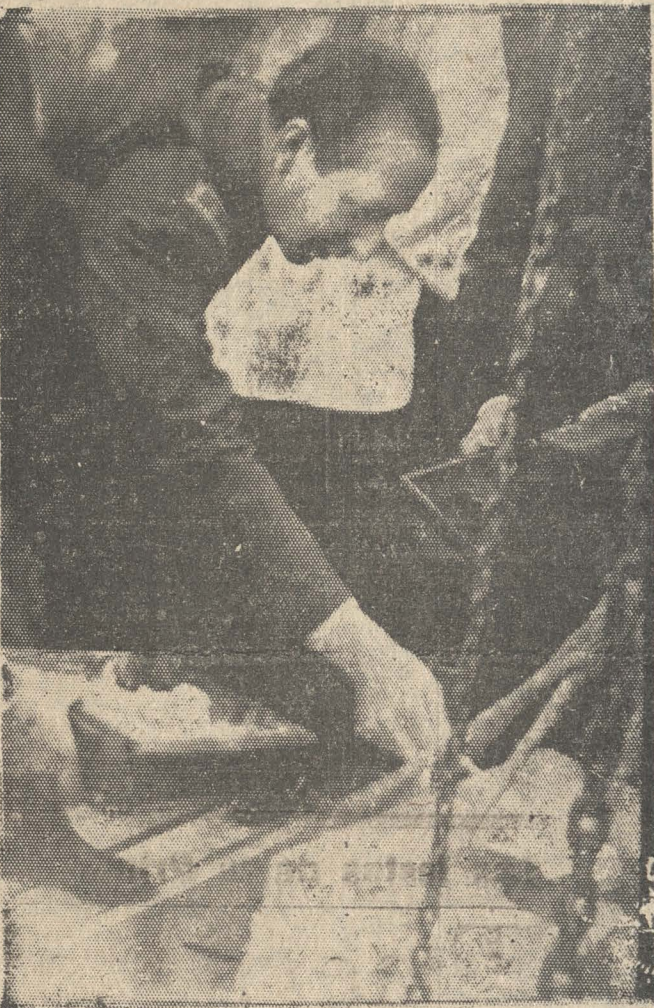
El jefe de la III División, general don Armando Solari Parra, coloca la mezcla con cemento sobre la primera piedra.
