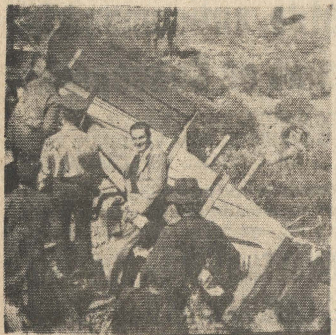
Este es el carro de la reconstrucción que sufrió la quebradura de un eje, al llegar a Penco. Ha sido retirado de la vía a objeto de que quede expedita
