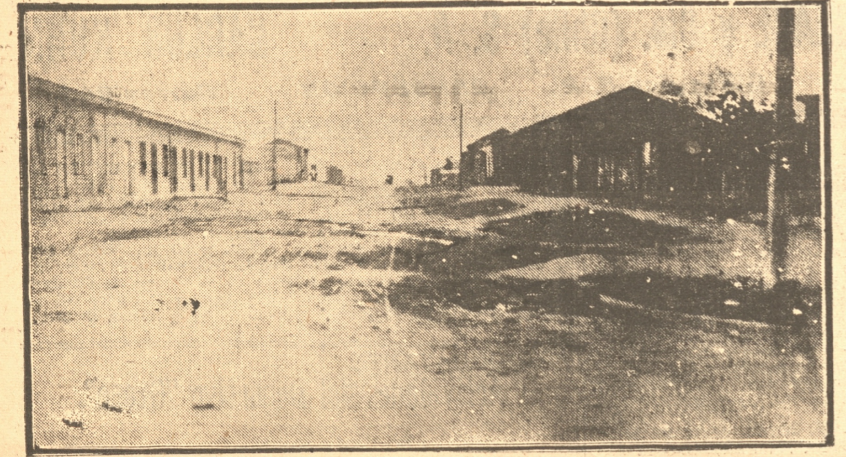
LA AVENIDA ARGENTINA, EN EL SECTOR DONDE AUN NO HAN COMENZADO A EJECUTARSE LOS TRABAJOS. — COMO SE, BIEN POCO PARECIDO TIENE A UNA CALLE
