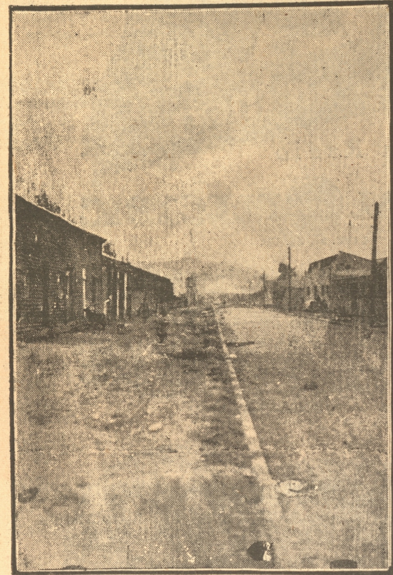
El trecho de la Avenida Argentina, donde ya existen veredas y calzadas. — Los trabajos de adoquinado en ese sector van ya muy adelantados.
