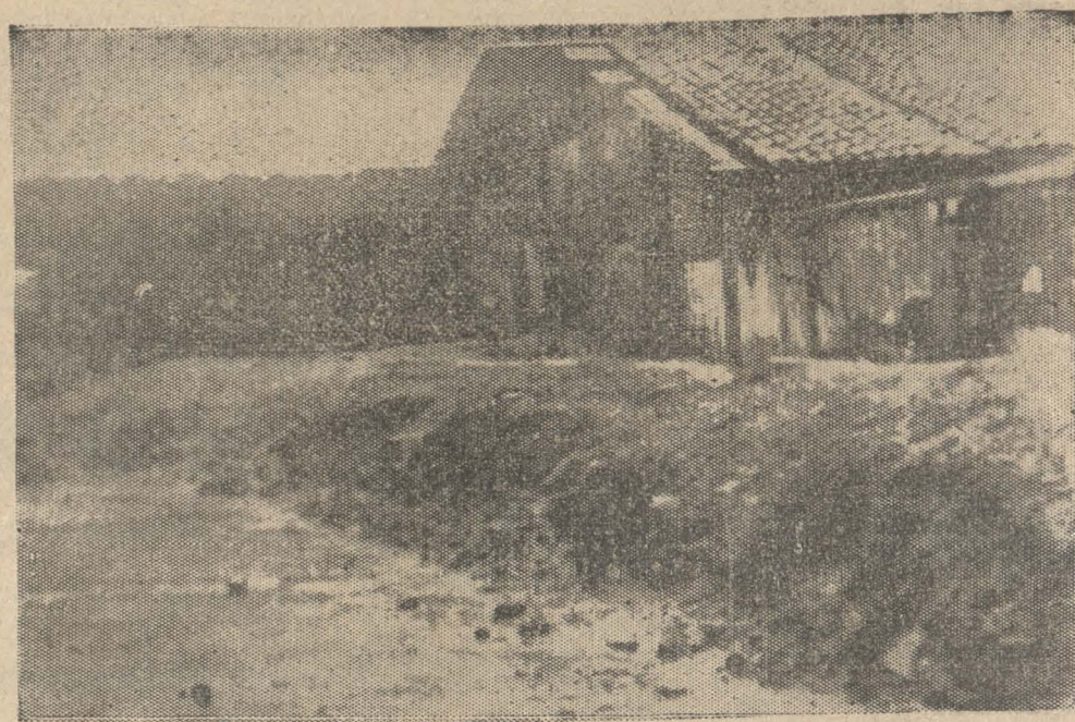
Un aspecto interior de la cárcel donde antes se encontraba ubicada la oficina del Alcaide y la sala de guardias
