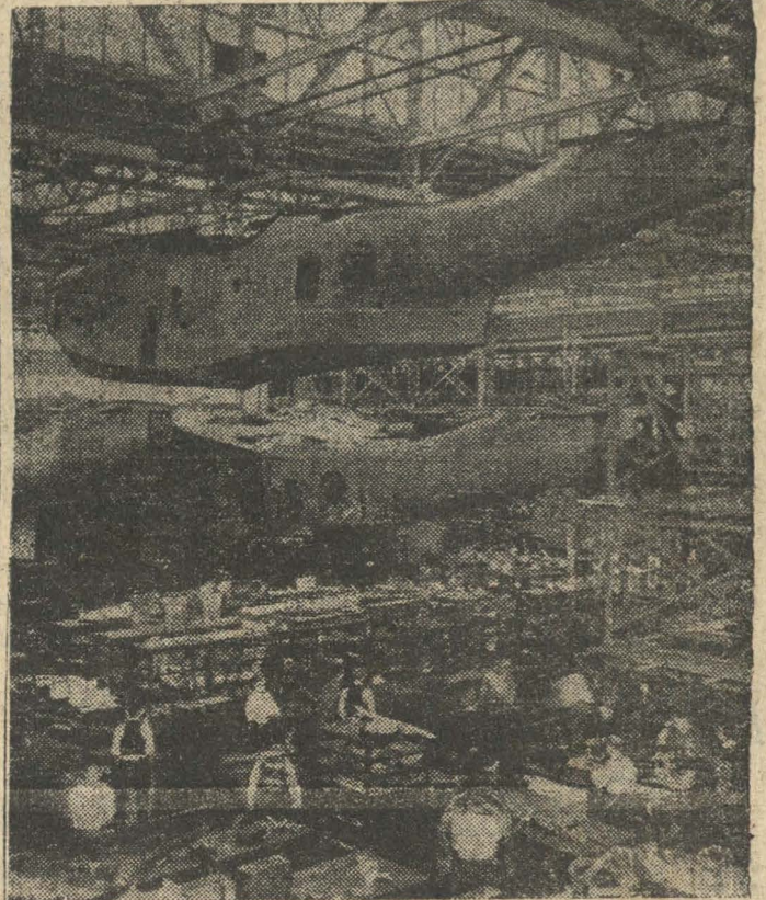
Este Leviatán del aire, todavía sin alas, hace su primer vuelo en la fábrica de Glenn L. Martin, de Baltimore, Maryland, al ser conducido de una parte a otra por medio de un grúa. Es de 29 toneladas, y se destinará a patrullar el litoral americano. En la fábrica se produce un avión por semana. (Foto de la I. I. News)
