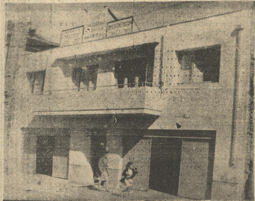
Edificio construido por los arquitectos señores Zaccarelli, Gacitua y Barbieri en calle Maipú entre las de Coto Colo y Castellón. Su estilo, es el de la mayor parte de las nuevas construcciones que empiezan a elevarse sobre las ruinas de la vieja ciudad.
