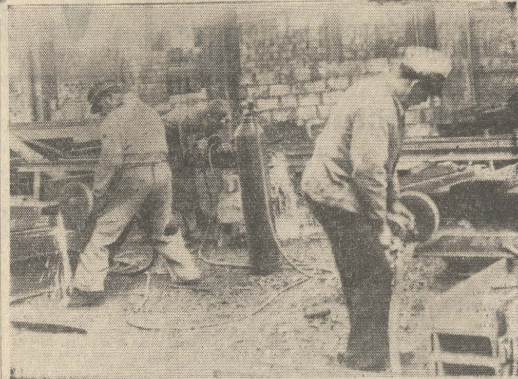
Mientras un obrero solda al oxígeno, otros dos pulen los terminales de dos piezas. — Por donde se mire hay actividad en la Maestranza.
