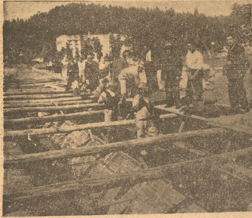
VISTA DE LOS TRABAJOS DEL ESTERO LAS POCITAS
