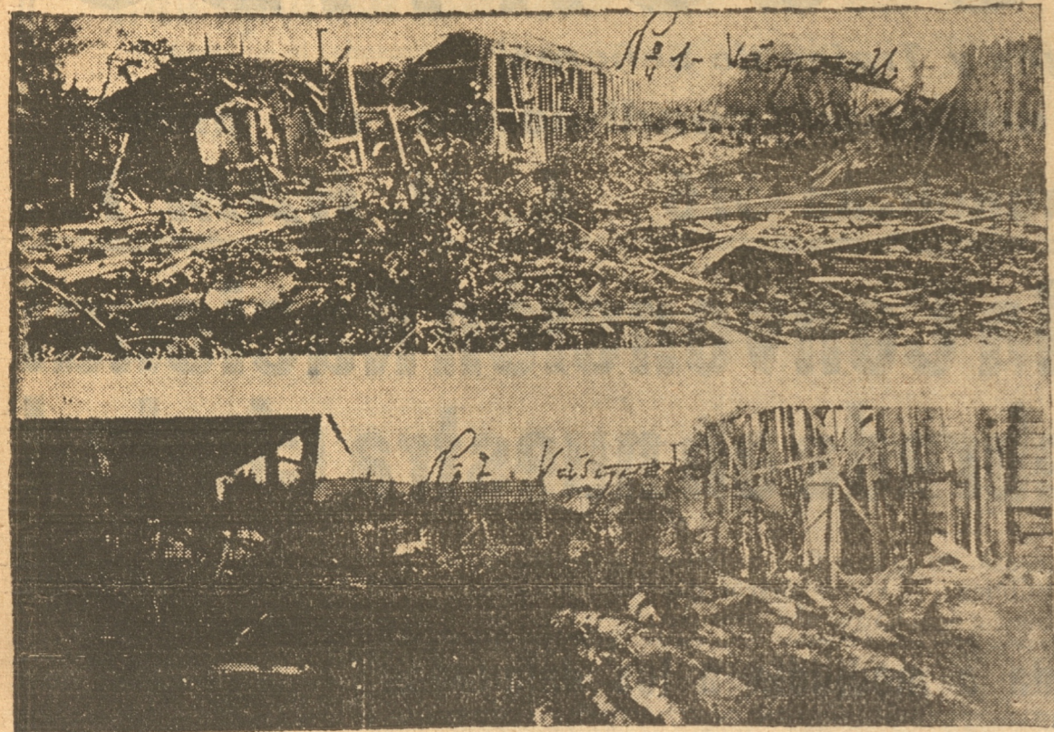
Damos dos vistas del estado en que quedó el edificio del aserradero y molino de propiedad de la señora Libertina Moraga y de Alvarado, ubicado en Coelemu, donde hace pocos días ocurrió la explosión del caldero de un motor, que produjo cuatro víctimas y sobre cuyo accidente dimos amplias informaciones en su oportunidad.
