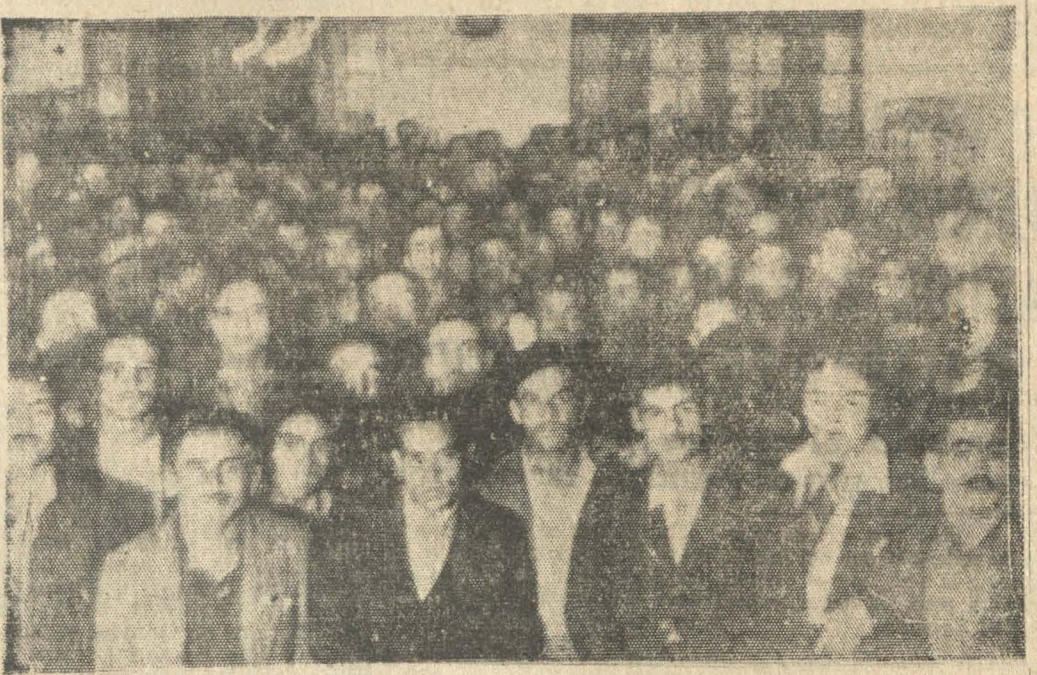
Miembros del Sindicato de la Construcción de la Empresa Boni, que ayer visitaron nuestro diario, para exponer la situación a que se ven abocados con la paralización de las faenas que produce en las obras de reconstrucción la falta de cemento.
