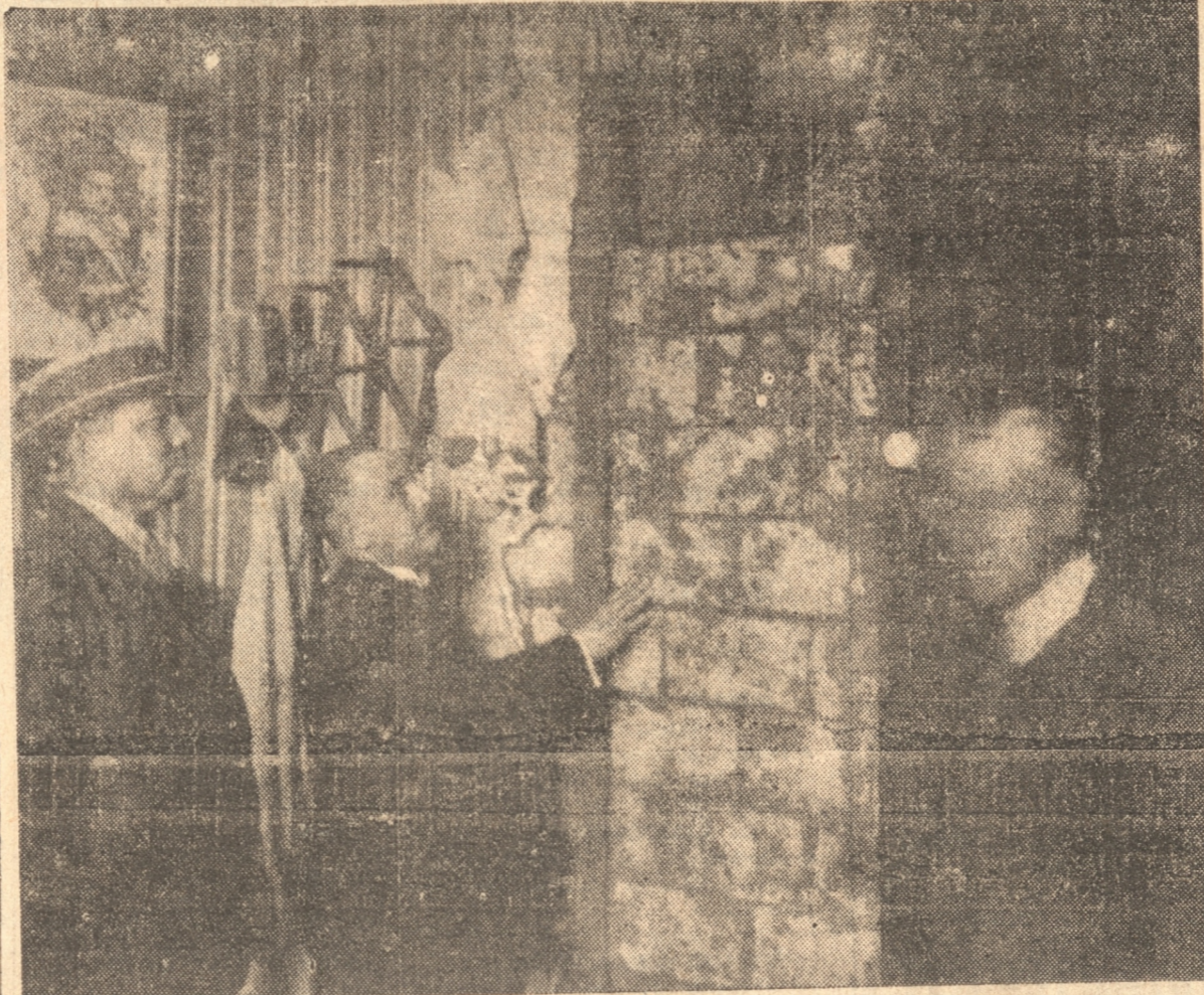
EL DIPUTADO SEÑOR ARNECHINO OBSERVA UNO DE LOS MUROS DE UNA DE LAS CASAS. COMO ESOS DESPERFECTOS HAY MUCHOS QUE HAN HORRORIZADO A TODOS LOS QUE VISITAN LA POBLACION SIN EL ESPIRITU PRECONCEBIDO PARA ENCONTRAR TODO BUENO
